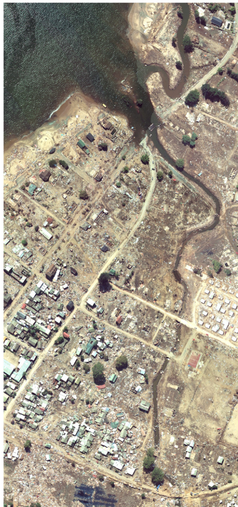
Fotografía aérea después del terremoto Servicio Aerofotogramétrico (SAF), 3 de marzo
